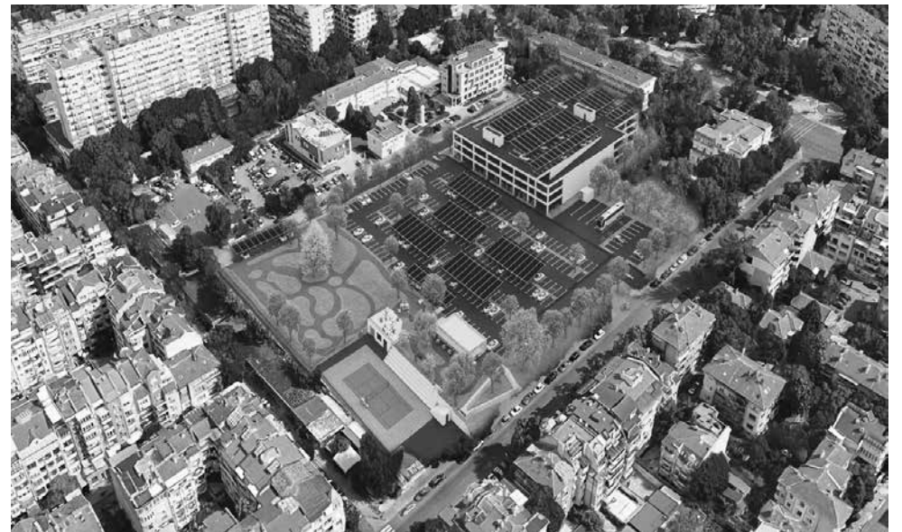
Вторият проект обхваща разширение на съществуващия паркинг на ул. „Гурко“, като целта е капацитетът му да бъде значително увеличен
