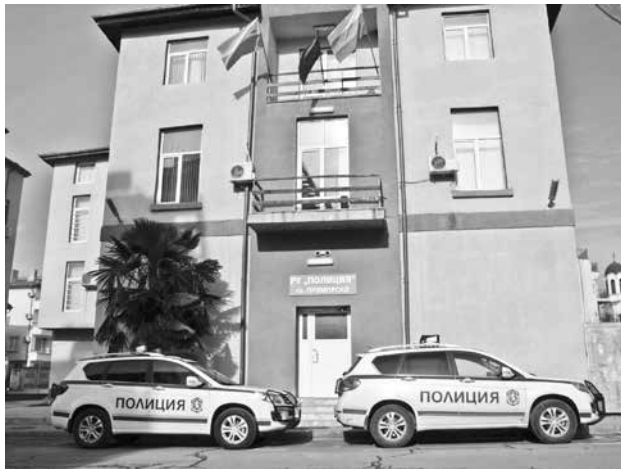
В сградата на РУ-Приморско ще бъде изградена фотоволтаична система, която ще позволи използването на възобновяема енергия
